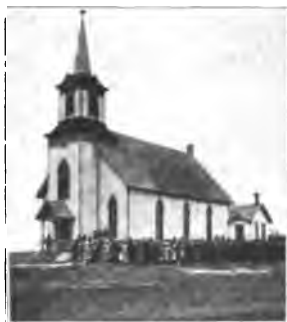
Kirke, 1886, $4,350. Prestehus 1, 1881, $500. Prestehus 2, 1892, $1,200. Gravplads, 2¼ acres.
